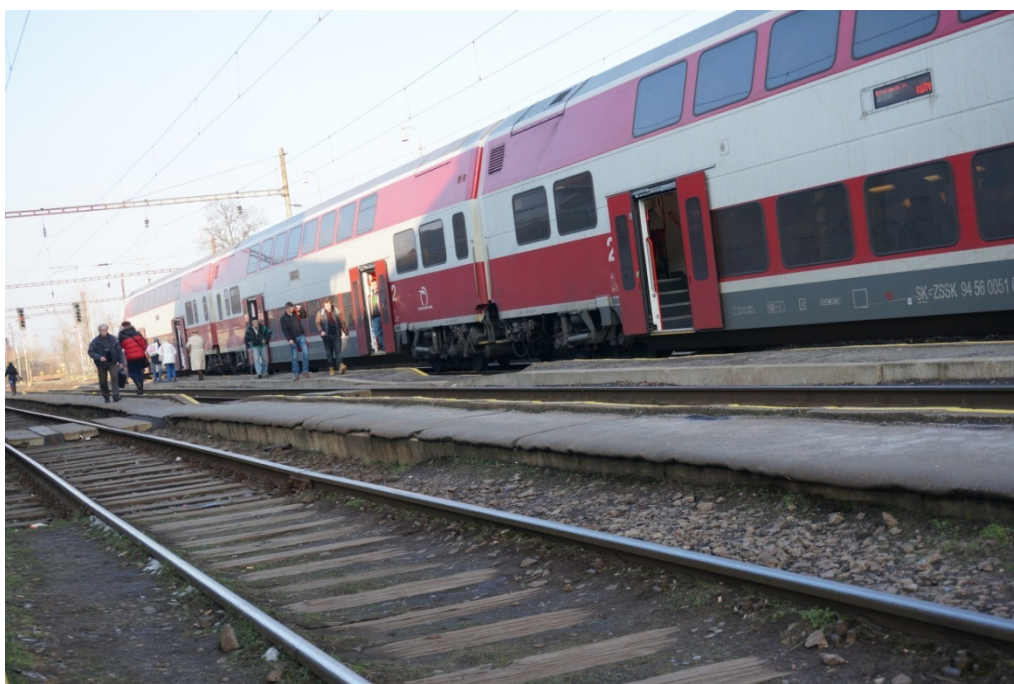
Obr. 1 Prístup k vlaku v žst. Malacky sa vyznačuje úrovňovým prechodom v koľajisku a absenciou nástupísk
